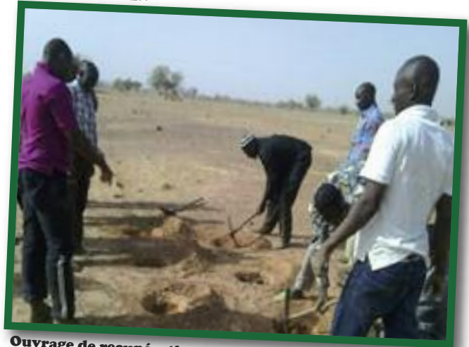
Ouvrage de récupération de terres à Torodi
